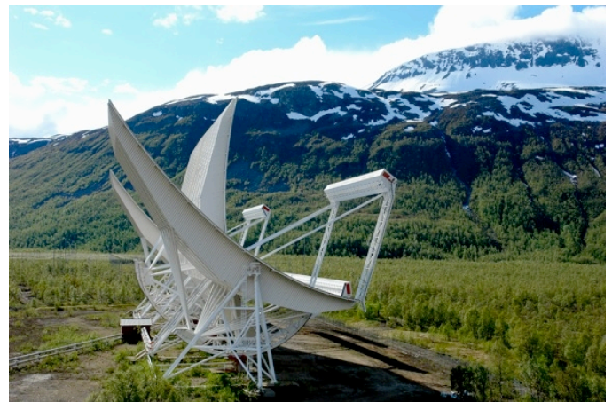
Fig. 4. The EISCAT VHF antenna in Tromsø (Lars-Göran Vanhainen).
